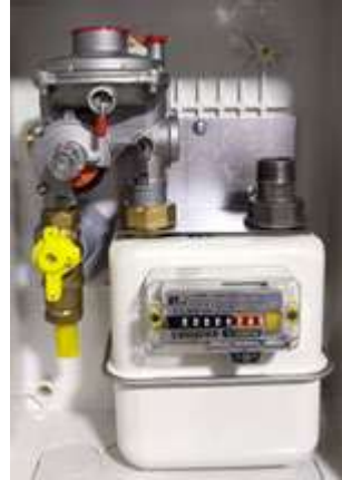
Medidores de desplazamiento positivo tipo diafragma para gas natural O L.P NOM-014-SCFI-1997
